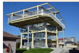
(津波避難タワー)
